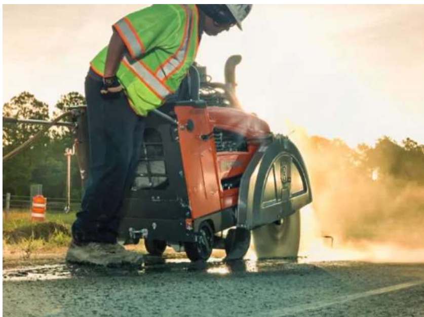
Figura 1: Corte de pavimento asfáltico com disco diamantado.
