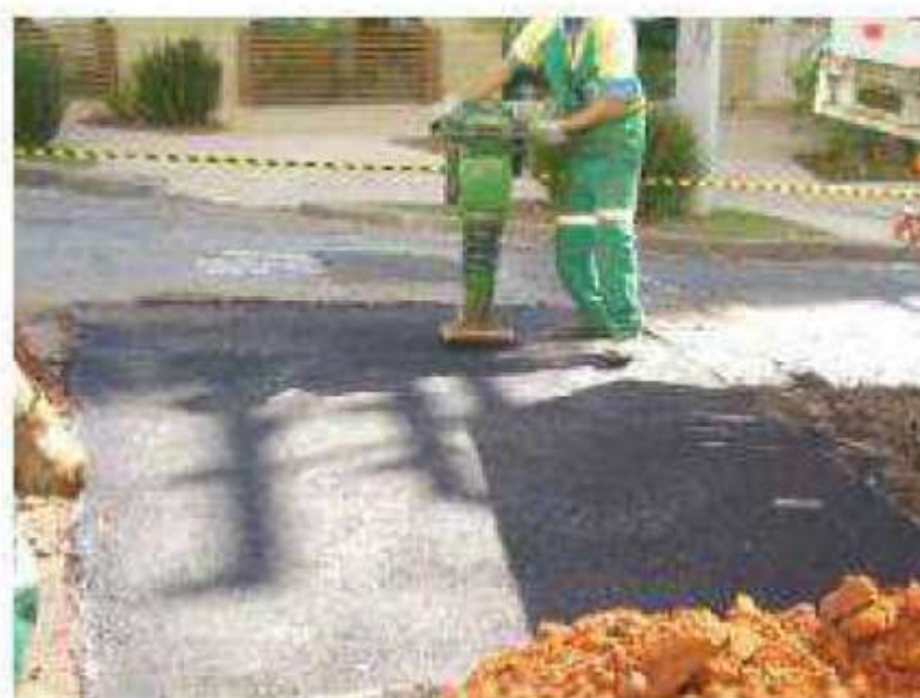
Figura 4: Aplicação e compactação do C.B.U.Q.
