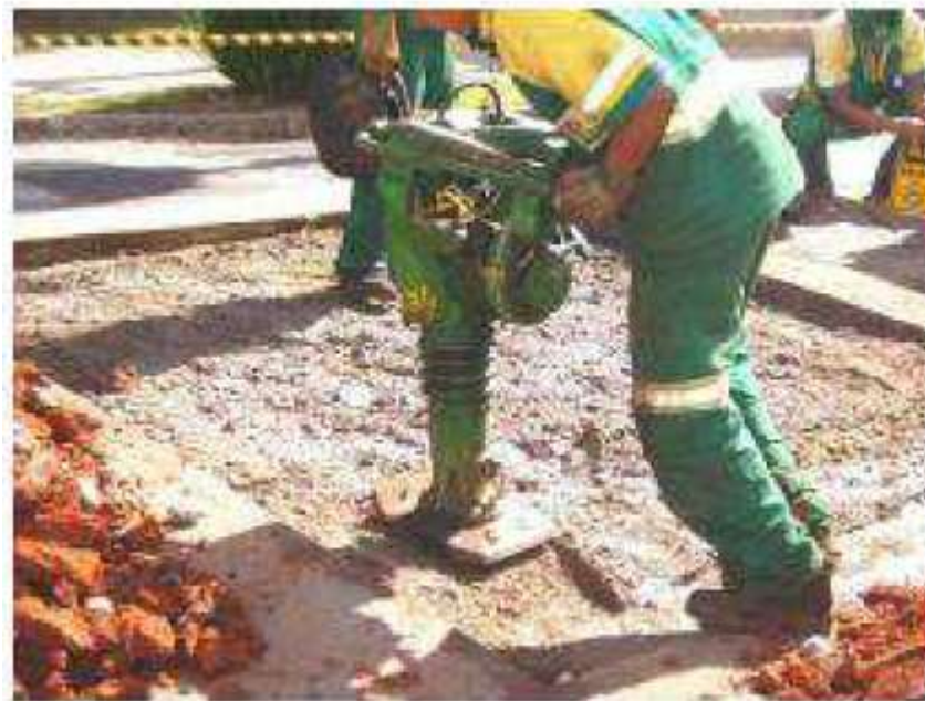
Figura 2: Readequação da camada de base.
