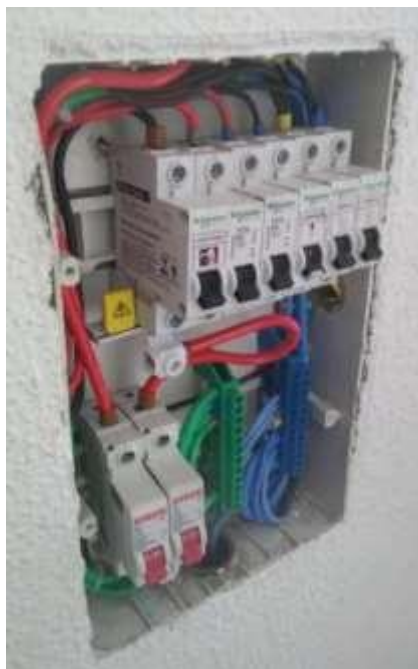
Figura 20: Quadro de Distribuição Monofásico
