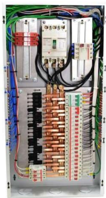
Figura 20: Quadro de Distribuição Monofásico
