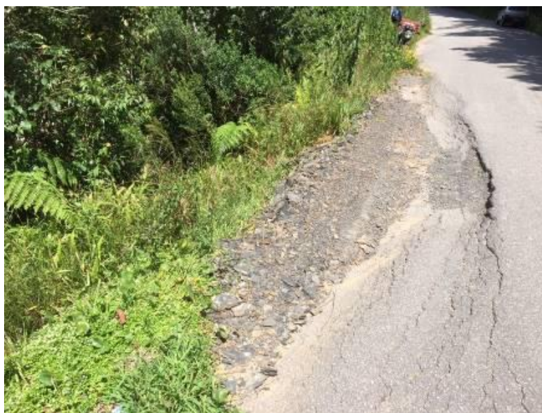
FOTO 07 – FOTO DO PAVIMENTO DANIFICADO. UM DEGRAU JÁ FOI FORMADO CONFORME PODE SER VISUALIZADO EM FOTO. ESTA ESTRADA É A VIA QUE CONECTA O DISTRITO DE TAQUARAS COM O CENTRO DE RANCHO QUEIMADO E ESTA VIA É ESTRATÉGICA PARA O MUNICÍPIO
