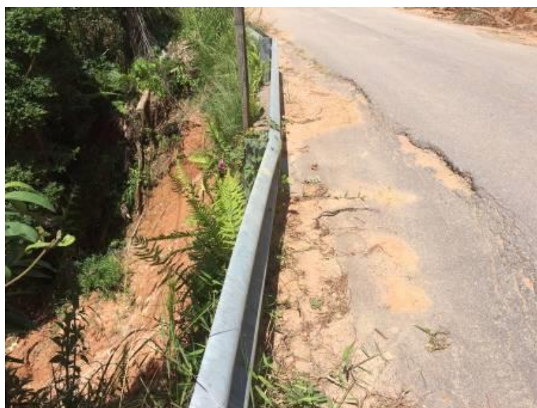
FOTO 03 – FOTO DA ESTRADA. DEVIDO AS CHUVAS A ÁGUA SE INFILTRA NA BASE DO PAVIMENTO E TORNA O MESMO AINDA MAIS FRÁGIL, CONTRIBUINDO PARA ACELERAR A DESTRUIÇÃO DA ESTRADA. ESSA CONDIÇÃO CAUSA ACIDENTES NA ESTRADA. É POSSÍVEL OBSERVAR O DESNÍVEL NA PISTA NA FOTO.
