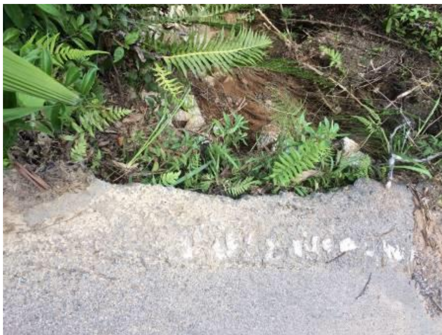
FOTO 11 – FOTO DA BEIRA DA ESTRADA NO PONTO 4. DEVIDO A PROXIMIDADE COM O RIO A DIFICULDADE PARA UMA CONTENÇÃO COM CORTINA ATIRANTADA É MUITO GRANDE LOCALIZAÇÃO PONTO 04: LATITUDE: 27° 38' 34,30" SUL E LONGITUDE: 49° 06' 08,61" OESTE
