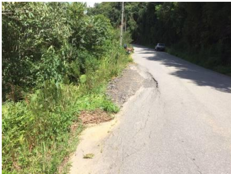
FOTO 06 – FOTO DO PONTO 03. CONTER O TALUDE EVITARIA TAMBÉM A DESTRUIÇÃO DA VIA E A TORNA MAIS SEGURA
