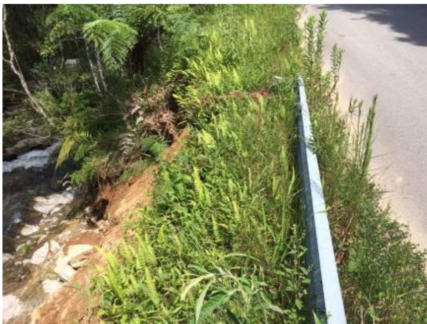
FOTO 05 – FOTO NO PONTO 02. AINDA NÃO EXISTE DANO NA ESTRADA MAS EXISTE A POSSIBILIDADE DE DESESTABILIZAR AINDA MAIS O TALUDE
