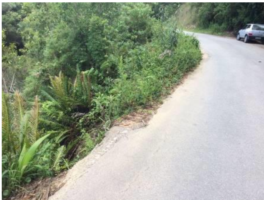
FOTO 10 – FOTO DO PONTO 04. UMA CONTENÇÃO ATRAVÉS DE UM MURO DE CONCRETO ARMADO OU UMA CORTINA ATIRANTADA SOLUCIONARIA A SITUAÇÃO LOCALIZAÇÃO PONTO 04: LATITUDE: 27° 38' 34,30" SUL E LONGITUDE: 49° 06' 08,61" OESTE
