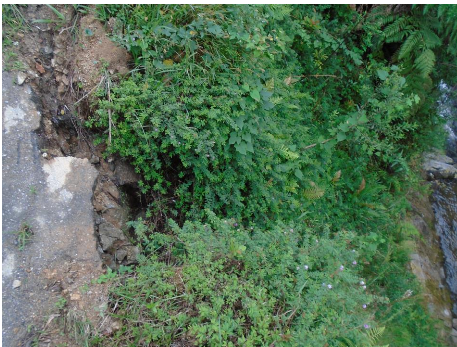
FOTO 13 – FOTO DA BEIRA DA ESTRADA NO PONTO 4. A PROXIMIDADE COM O RIO BONITO AUMENTA A DIFICULDADE DE EXECUÇÃO DE UM MURO. UMA ALTERNATIVA VIÁVEL SERIA A CONSTRUÇÃO DE UM MURO DE CONCRETO CICLÓPICO LOCALIZAÇÃO PONTO 04: LATITUDE: 27° 38' 34,30" SUL E LONGITUDE: 49° 06' 08,61" OESTE
