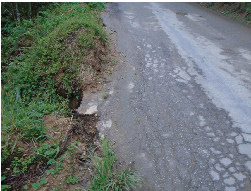
FOTO 08 – FOTO DO PAVIMENTO DANIFICADO.
