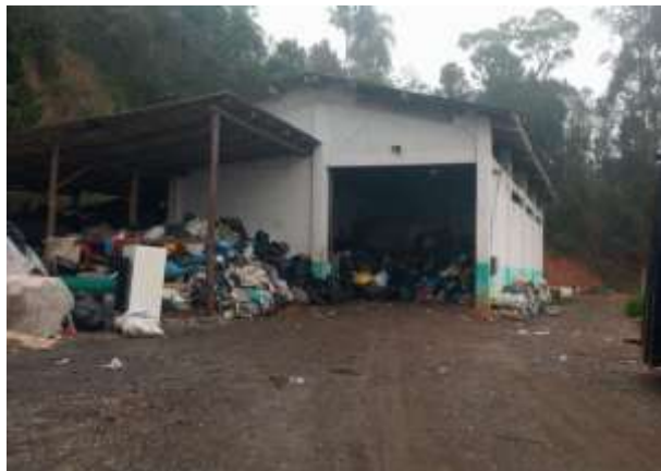
Figura 22: Galpão de triagem.
